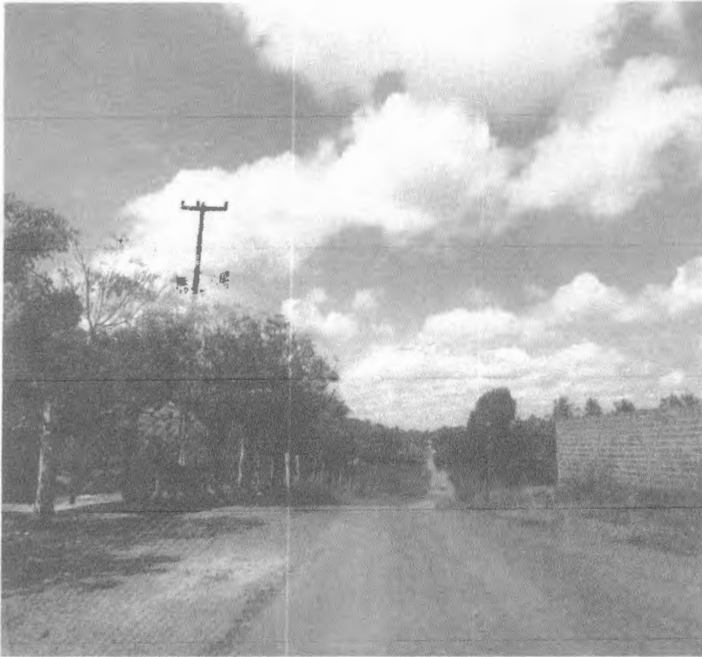
Trecho executado ligado entre a MA-034 e ao povoado gato zona rural de Passagem Franca-Ma.
