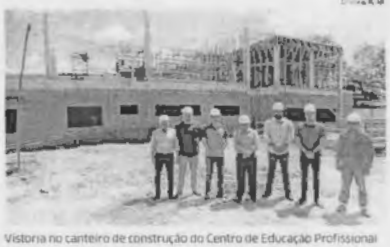
Visita no canteiro de construção do Centro de Educação Profissional
