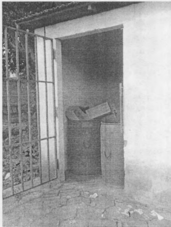
Figura 5 – Abrigo dos Resíduos de Serviço de Saúde Fonte: Pesquisa Direta, 2014.
