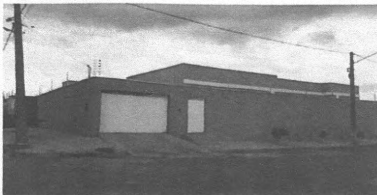
Imagem 01: Fachada Frontal da obra
