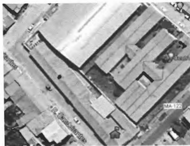
Figura 2. Vista aérea da Escola Municipal Laurentina Pereira Mota
