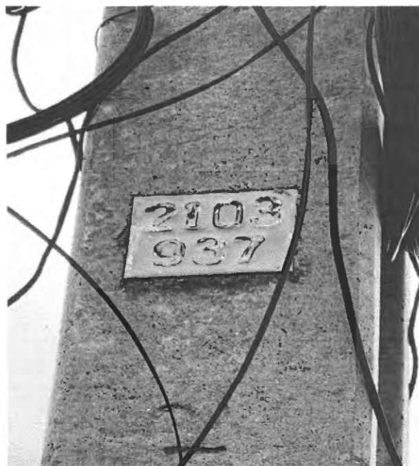
Figura 10. Poste da Escola Municipal Nicolau Dino
