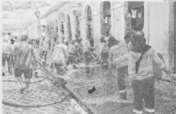
Operários trabalham na lavagem do calçadão do Mercado das Tulhas, melhorando a situação da área
