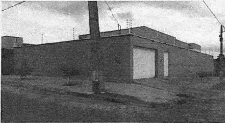
Imagem 02: Fachada Frontal e Lateral da obra
