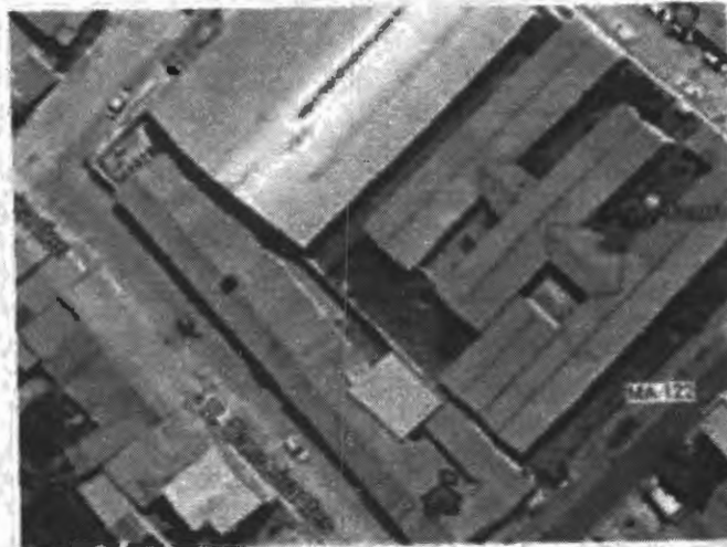
Figura 2. Vista aérea da Escola Municipal Laurentina Pereira Mota
