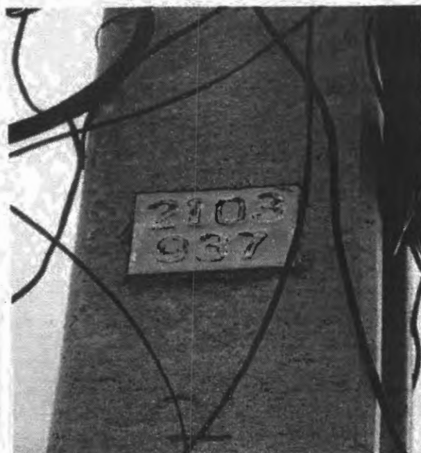
Figura 10. Poste da Escola Municipal Nicolau Dino
