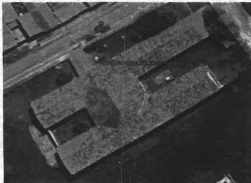
Figura 5. Vista aérea da Escola Municipal Paulo Madeira
