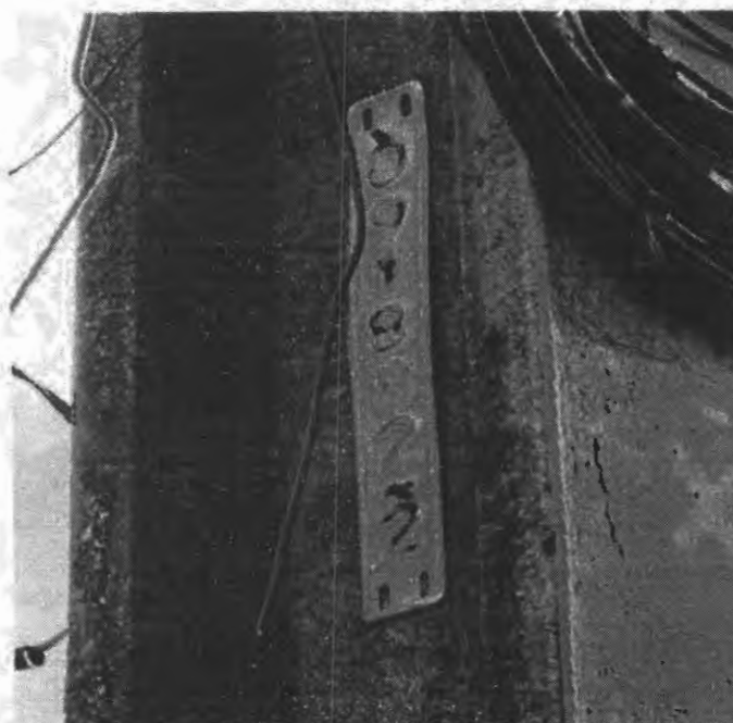
Figura 12. Poste da Escola Municipal Paulo Madeira
