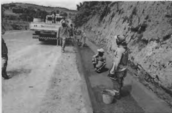
Pavimentação da MA-012 facilita o transporte da produção e o acesso das pessoas
