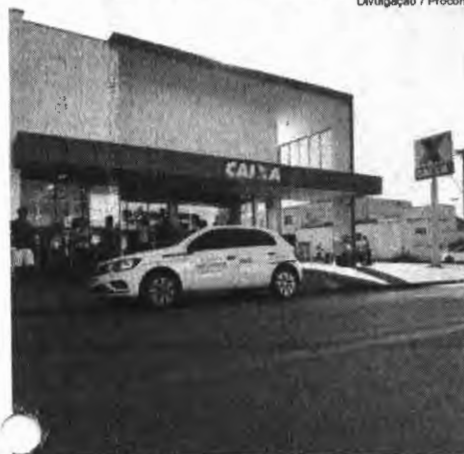
Agência da Caixa Econômica em Colinas do Tocantins
