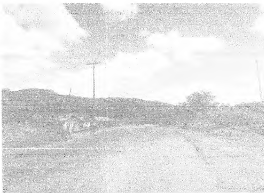
Tracho executado povoado Buntizinho que liga ao povoado gato zona rural de Passagem Franca-Ma
