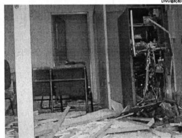
Caixa eletrônico e o interior da agência do Bradesco ficaram destruídos
