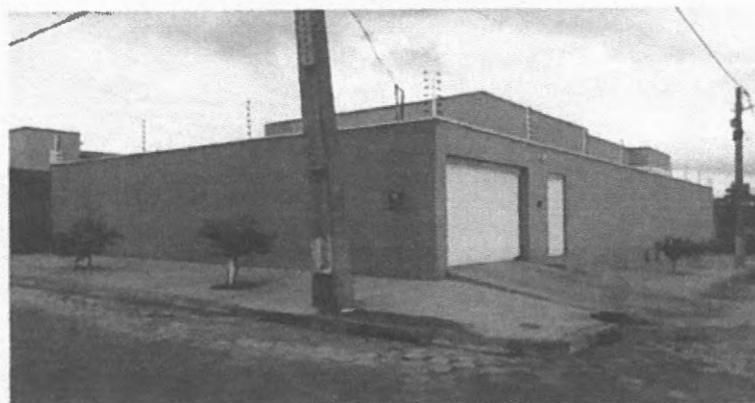
Imagem 02: Fachada Frontal e Lateral da obra
