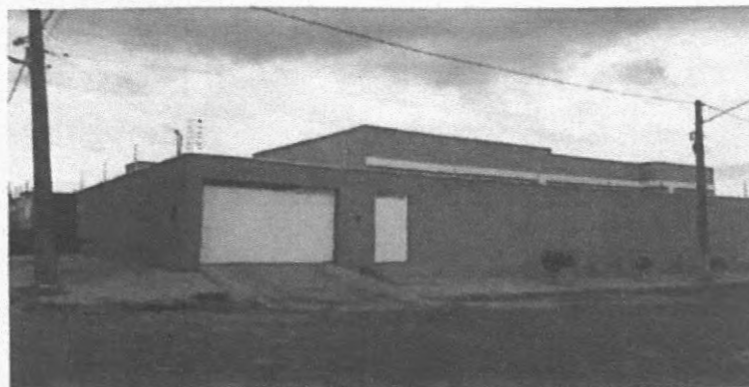
Imagem 01: Fachada Frontal da obra
