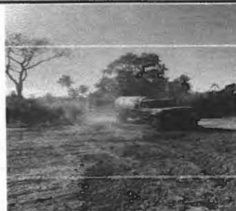
FOTO 05 - UTILIZAÇÃO DE CAMINHÃO PIPA PARA COMPACTAÇÃO
