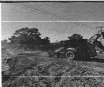
FOTO 02 - RETIRADA DA CAMADA COM MINIRETRO
