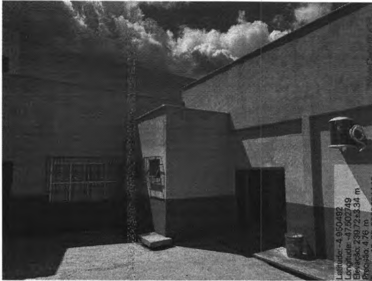
IMAGEM 10: ADAPTAÇÕES NO PRÉDIO JÁ EXISTENTE DA CÂMARA MUNICIPAL, CONSTRUÇÃO DE PLATIBANDA.
