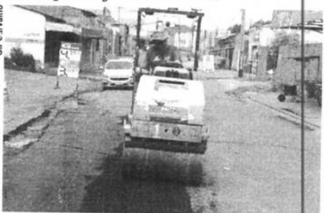
Equipe agilizadora recuperação da malha asfáltica na Rua Rui Barbosa, Vila Lobã
